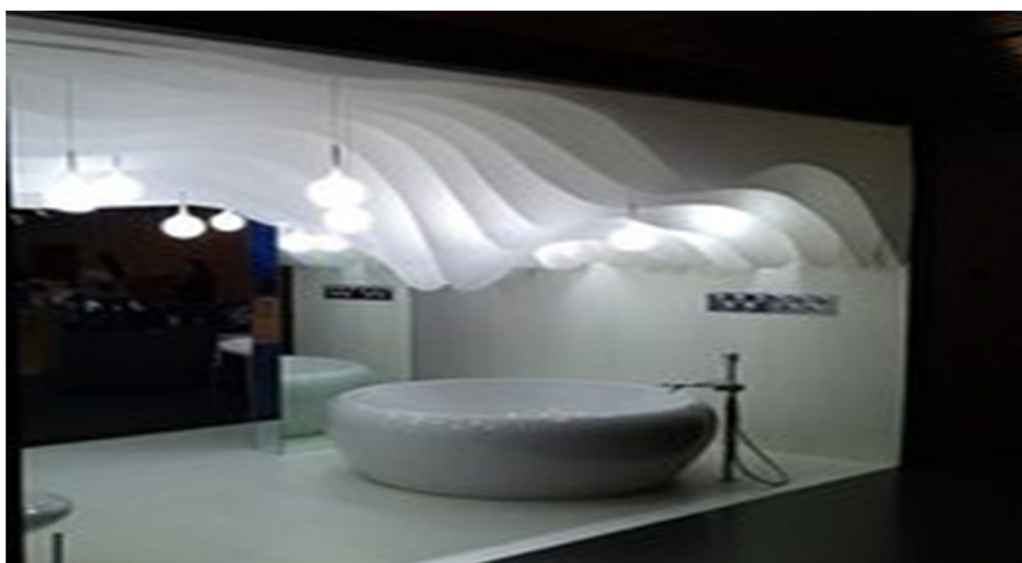
Рисунок 7 – Пример ламельного потолка в СПА-зоне
