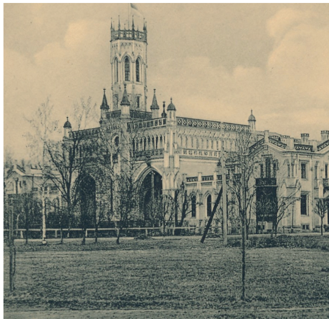
Вокзал в Петергофе, архитектор Н.А. Бенуа, 1855 г.
