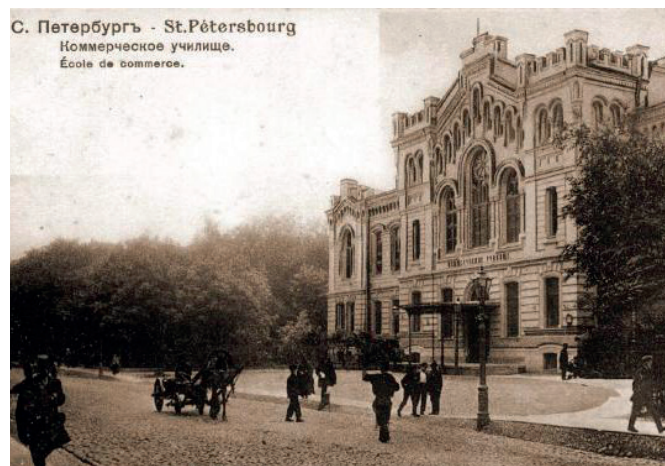
Дореволюционная фотография здания Императорского коммерческого училища на улице Чернышева (ныне – Ломоносова), 9, архитектор М. А. Макаров, 1869-1871 гг. Фото начало XX в.
